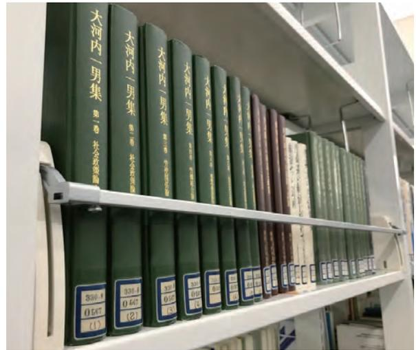
地震が来たときにバーが上がり、本の飛び出しを防ぎます。長さを調整できるので、他社製の書架も含め幅広く設置が可能です。振動台実験済み。
